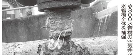
φ300水管橋の空気弁から漏水し、通水しながら水管橋全体を補強
