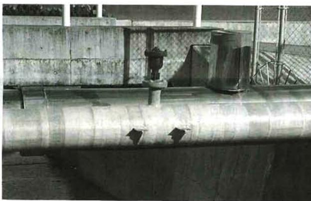
施工前（ラッキング撤去後）の配水管と「ウルトラパッチ」を貼付後の配水管
