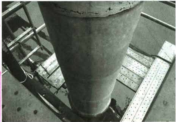
『ウルトラパッチ』での施工が完了
