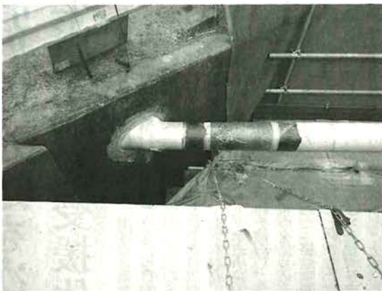
『ウルトラパッチ』での施工が完成(塗装して仕上げ)
