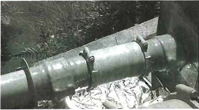
「ウルトラパッチ」で補修後は漏水発生せず
