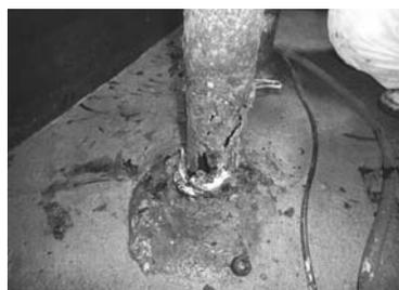
老朽化した沈殿池排泥管から漏水
