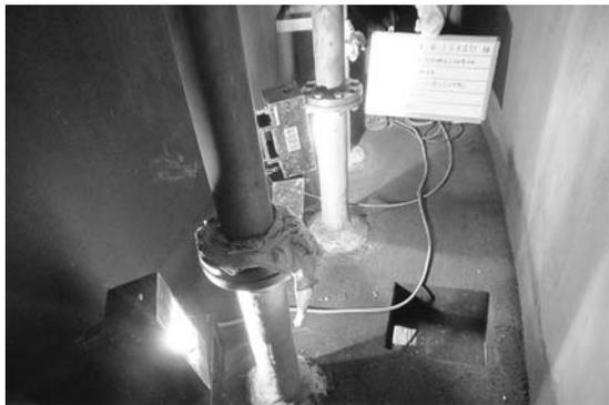
FRPシートを貼り付け紫外線照射で硬化
